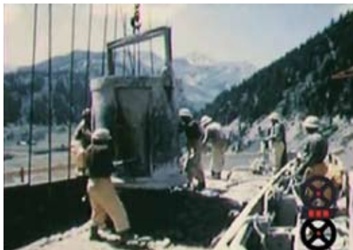
Construction du barrage de Saint-Guérin, Fonds EDF, 1956.
